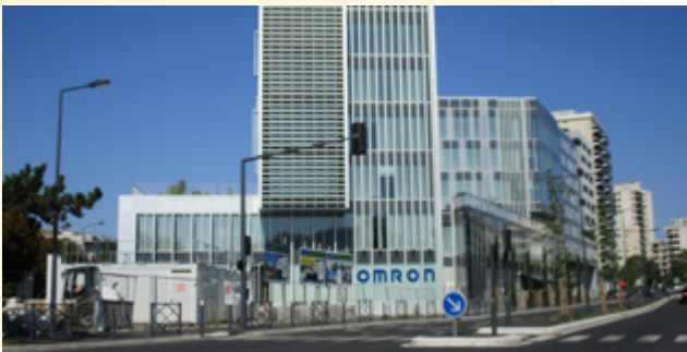
Immeuble Be Office - Nogent-sur-Marne SCPI Carac Perspectives Immo
